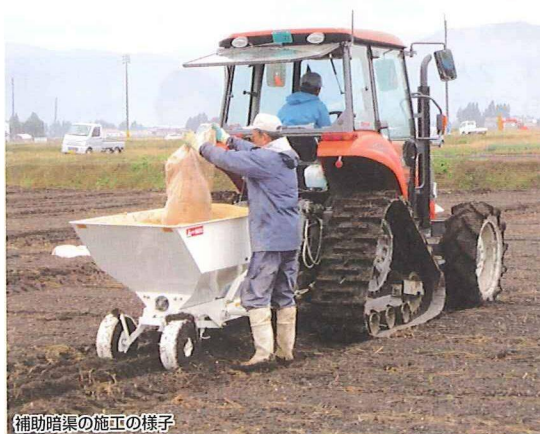
補助暗渠の施工の様子
